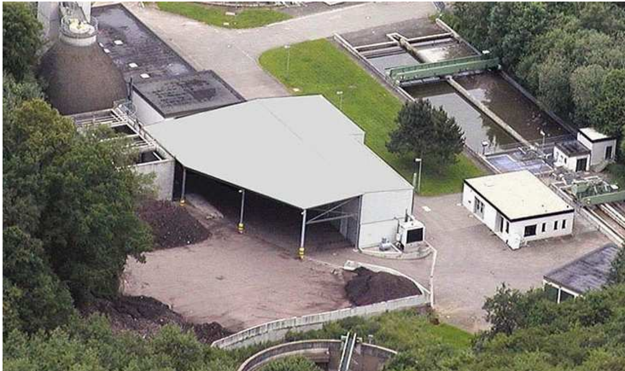
Abb. 1: Kompostierungsanlage für Klärschlamm und Grünschnitt auf der Kläranlage Beuerbach
