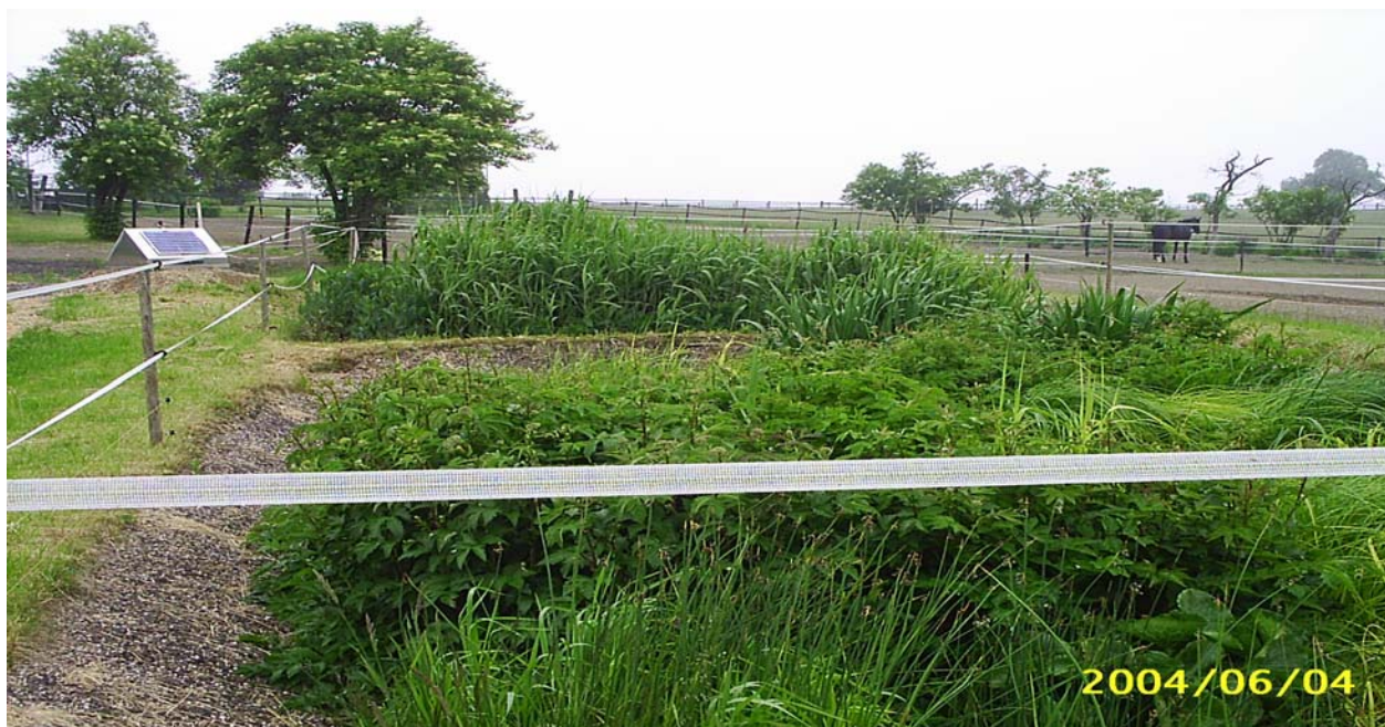
Abb. 1: Vordergrund: Reinigungsstufe-2 „Horizontal-BodenFilter; Hintergrund Solarschacht und Reinigungsstufe-1 „Vererdungsbeet 2v2“
